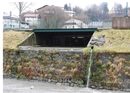
Figure 55 Parking ouvert sur le lit au P 1235
