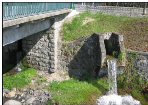
rejet du DN250 (sous le pont) et rejet du DN1000 (à droite)
