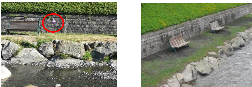
Figure 60 Repère et laisses de la crue de mai 2015
