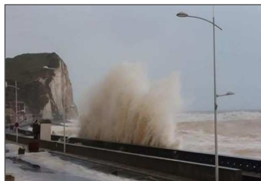
Figure 14 : Submersion marine par franchissement du système d'endiguement de Veulettes-sur-Mer lors de la tempête Éléonor (Source : CD76, Janvier 2018)
