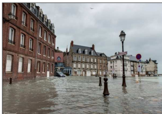
Figure 12 : Submersion marine par débordement à St. Valéry-en-Caux suite à la tempête Éléonor (Source : CD76, Janvier 2018)
