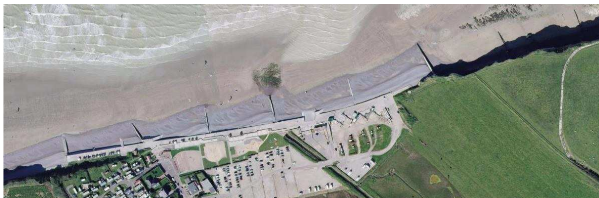
Figure 22 : Vue du système de protection du front de mer de Saint-Aubin-sur-Mer (source : CD76)
