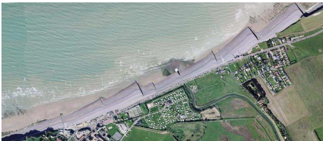
Figure 23 : Vue du système de protection du front de mer de Quiberville/St-Marguerite-sur-Mer (source : CD76)
