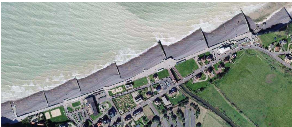
Figure 24 : Vue du système de protection de front de mer de Pourville-sur-Mer (source : CD76)
