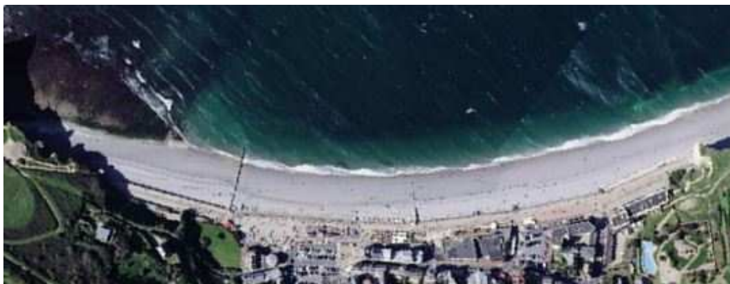
Figure 20 : Vue du système de protection du front de mer d'Étretat (source : CD76)
