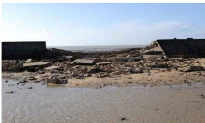
Figure 16 : Rupture de la digue de Quiberville-sur-Mer (Source : CD76, 1978)
