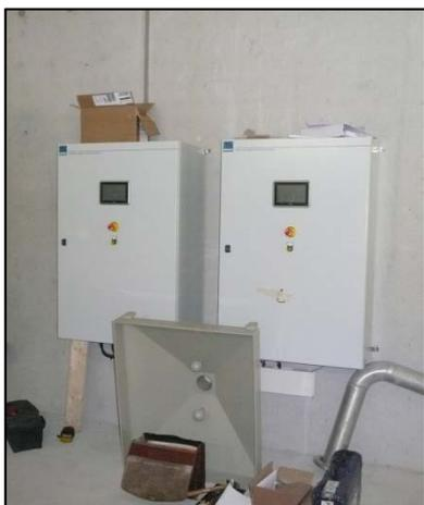
Figure 40 : Poste de supervision de la STEP du Markstein (filtre salsnes et modules d'électrofloculation) (source : BEREST)
