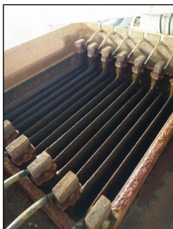
Figure 29 : électrodes du module d'électroflocculation de la STEP du Markstein (source : personne)
