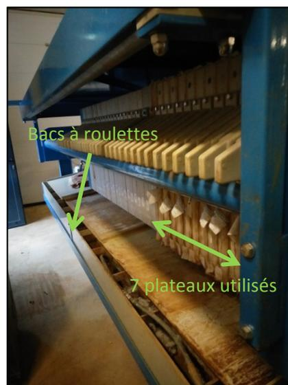
Figure 36 : Filtre presse à plateau de la STEP du Markstein (source : personnelle)
