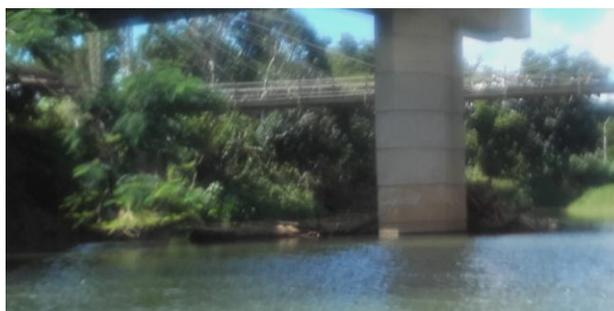
Figure 43. Embâcles retenus par le pont de la RT1
