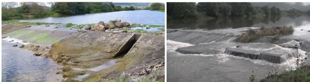
Figure 7. Etat du barrage anti-sel avant (photo de gauche) et après travaux (photo de droite).
