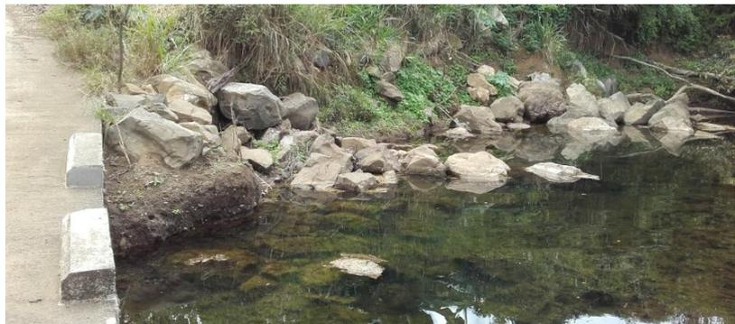
Figure 27. Etat des enrochements en amont du radier au PM4500 de la Pocquereux
