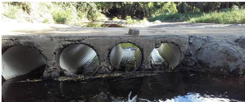
Figure 28. Radier en béton formé de 4 buses sur la Pocquereux en aval du PM6000
