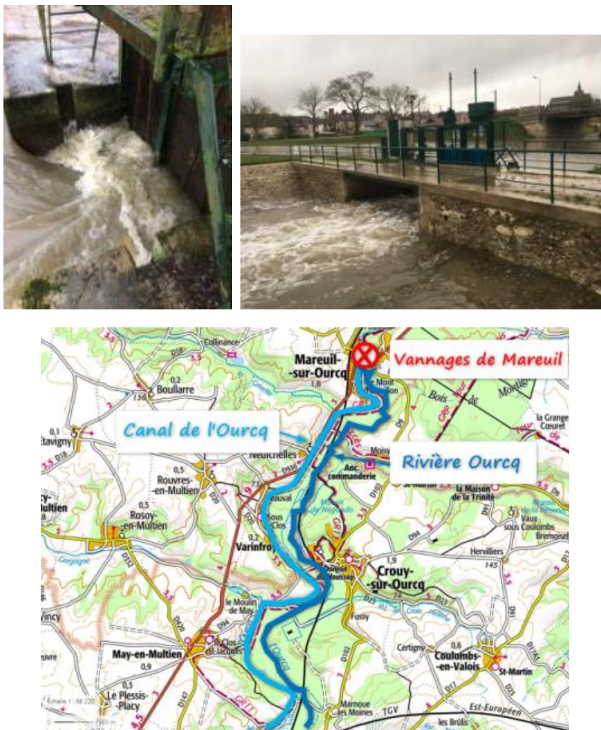
FIGURE 16 : VANNAGES DE MAREUIL (AMONT ET AVAL) ET LOCALISATION DES VANNAGES DE MAREUIL-SUR-OURCQ
