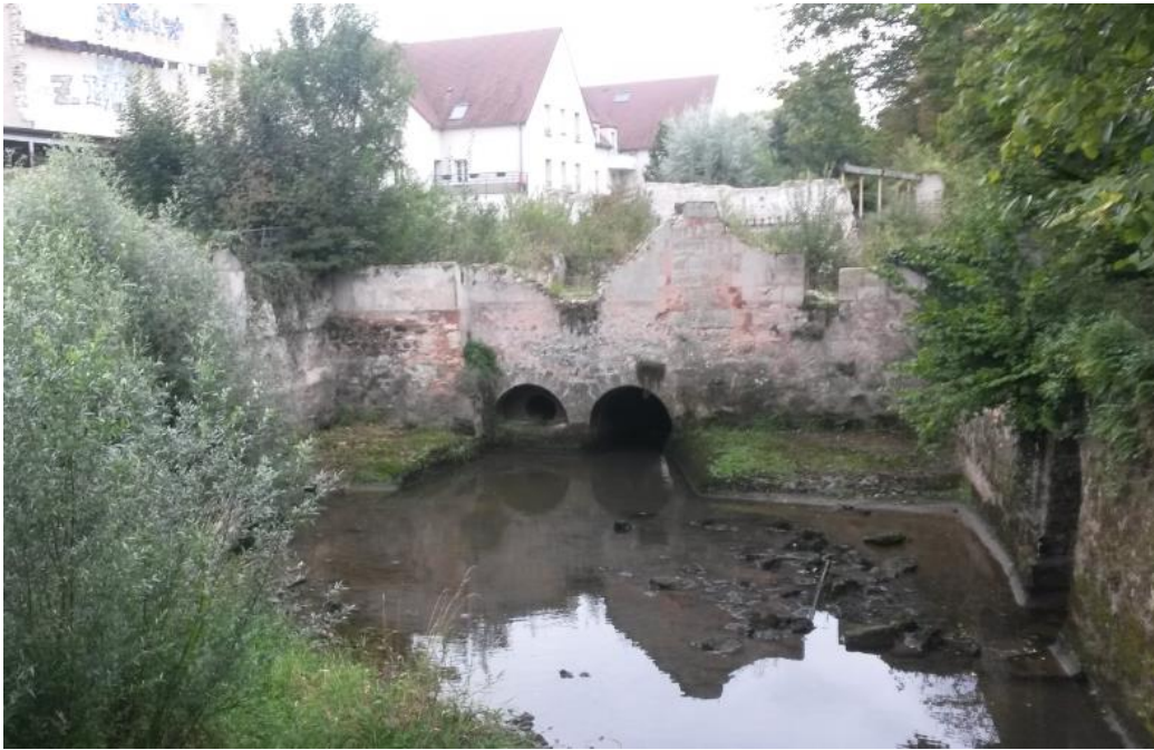
FIGURE 11 : BUSE AU NIVEAU DU MOULIN
