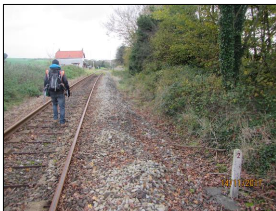
Figure 16. Vue du tronçon Pk 127+140 - Pk 127+200 depuis le Pk 127+200
