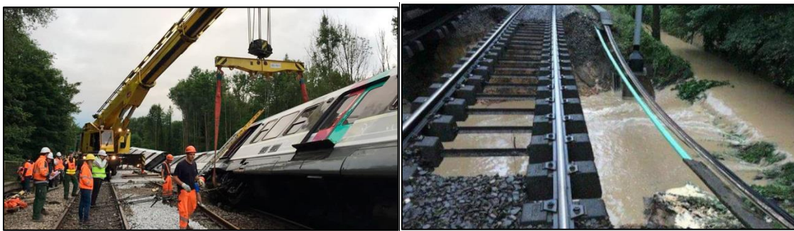
Figure 8. Photographies de l'affaissement de talus du déraillement du 14 juin 2018 – Source « Les Echos »
