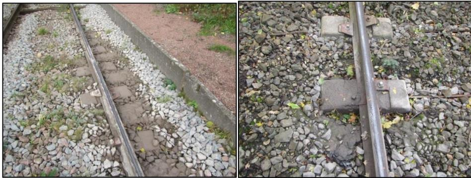
Figure 6. Photographies de remontées boueuses sur le projet Saint Pol – Source interne
