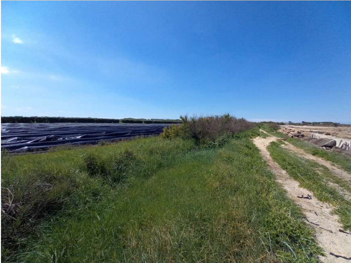
Figure 85 : Photographie de l'aménagement du champ de Pierre réalisé après une submersion marine, Réville (Mesnage, 2021)
