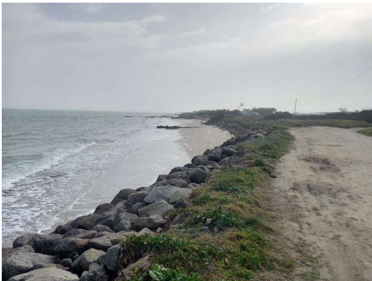
Figure 10 : Photographie des enrochements de Réville (Mesnage, 2021)
