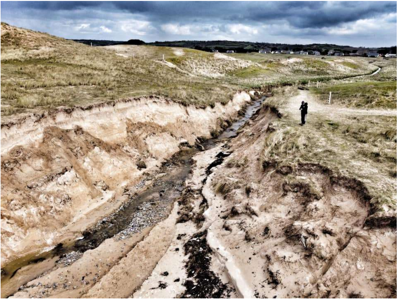
Figure 13 : Photographie de la brèche à Surtainville, le 7 février 2021 (Gaoudi, 2021)
