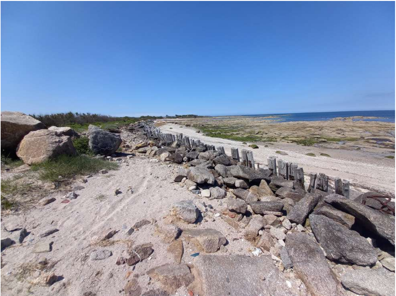
Figure 87 : Photographie des traverses de chemin de fer installées à Révile par l'ASA locale, (Mesnage, 2021)
