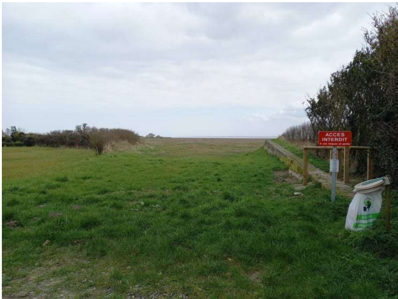
Figure 22 Digue face à un champ se trouvant sur une zone de marais, Sainte-Marie-du-Mont (Mesnage, 2021)
