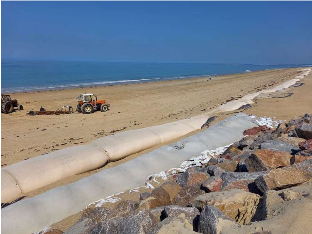
Figure 19 : Photographie des big bags se trouvant sur la plage de Gouville-sur-Mer (Mesnage, 2021)
