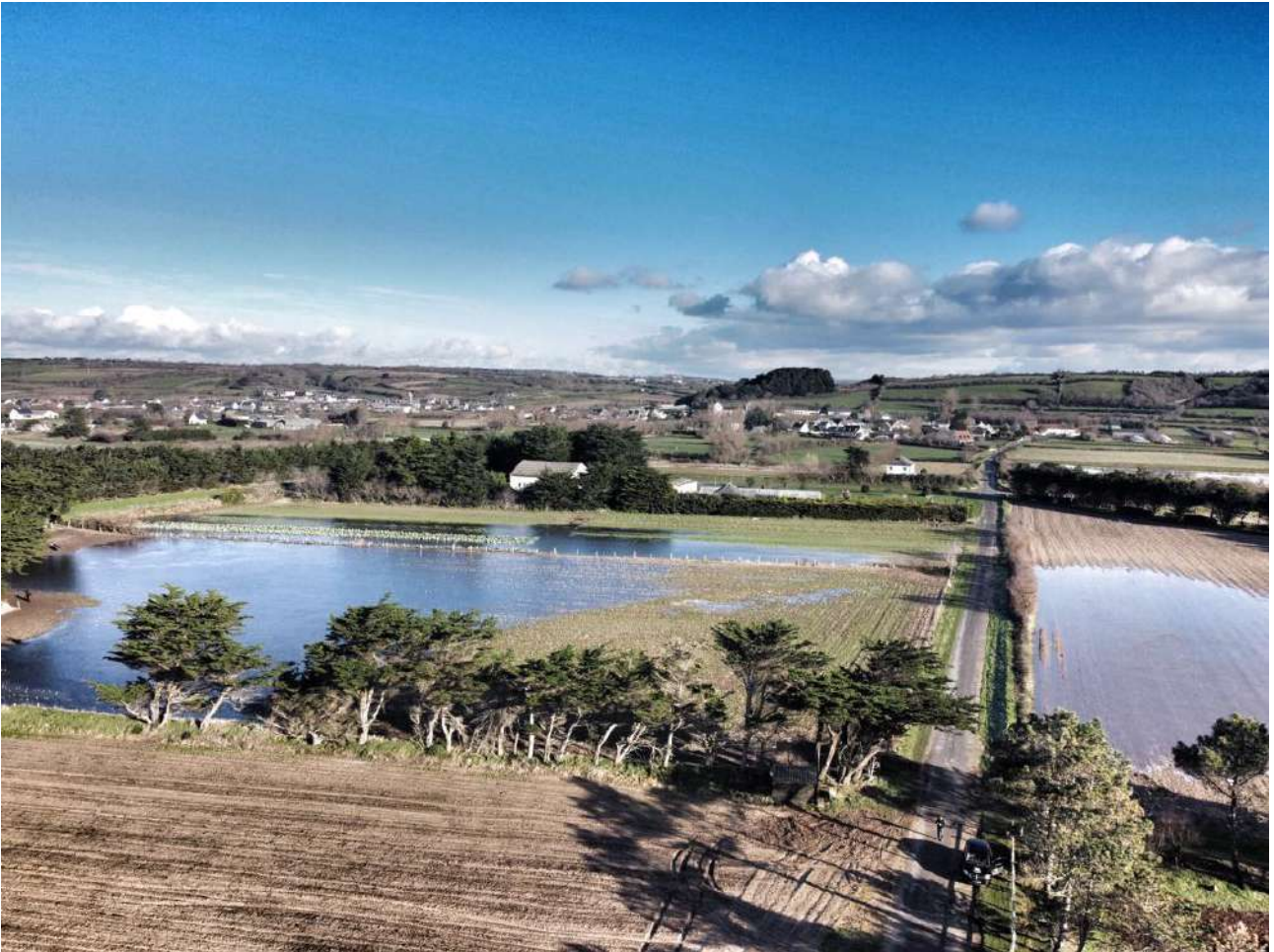
Photographie de champs subissant un débordement de nappe, Surtainville, janvier 2021 (Gaoudi, 2021)
