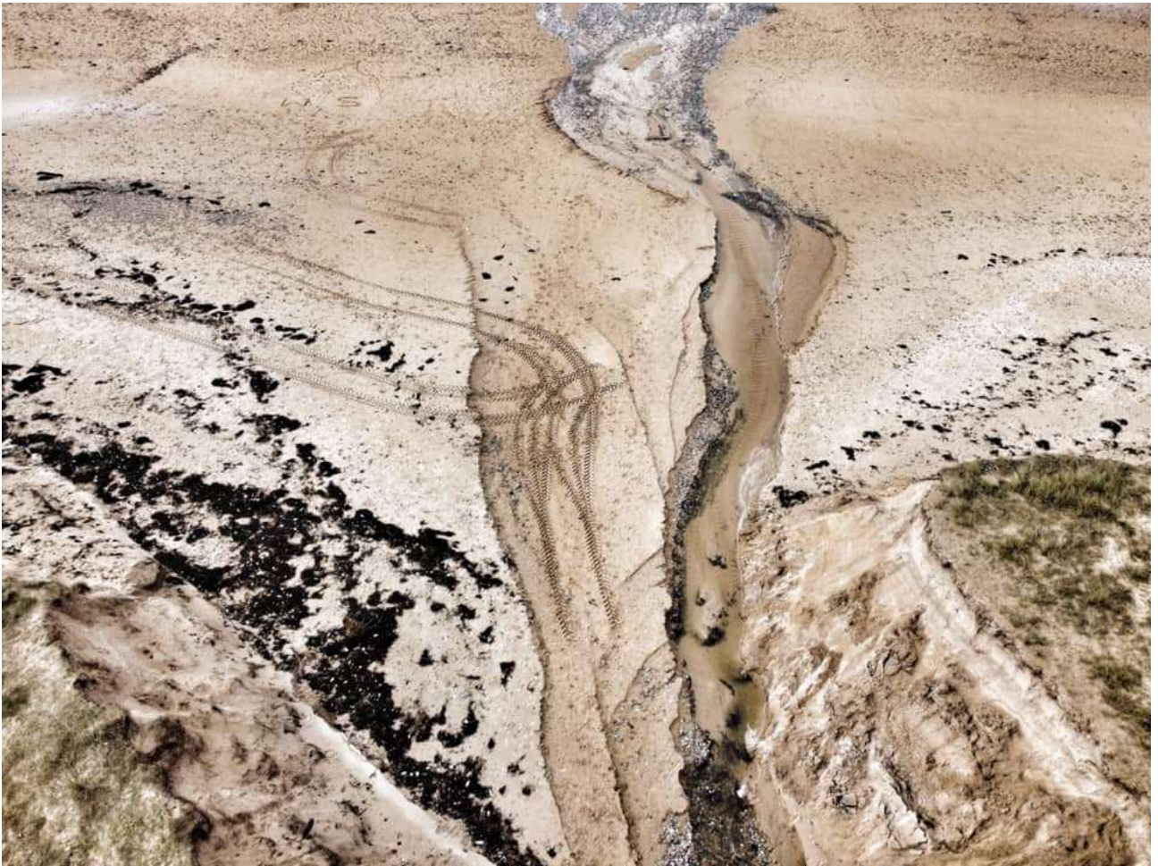
Photographie de la brèche à Surtainville, le 7 février 2021 (Gaoudi, 2021)
