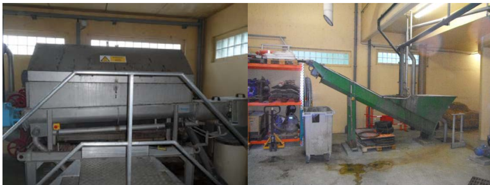
Tamis rotatif et classificateur à sables existant
