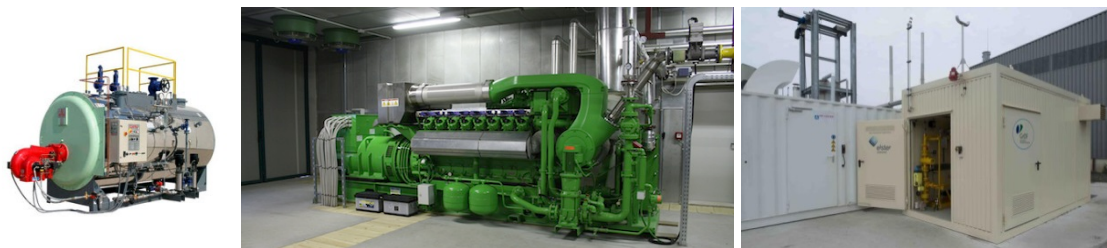
Figure 8 : Chaudière biogaz, unité de cogénération, poste d'injection réseau
