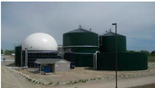
Figure 7 : Deux digesteurs et un gazomètre
