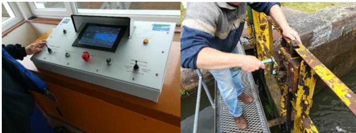
Figure 28 A gauche, un IHM présent dans chaque écluse (l'automate est derrière) et à droite un agent travaille sur la vantelle de l'écluse 18
