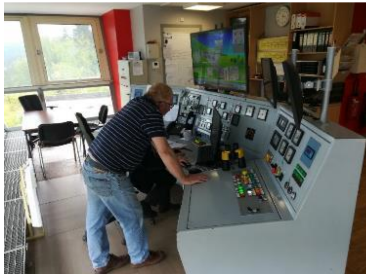
Poste de contrôle du Plan Incliné d'Arzwiller
