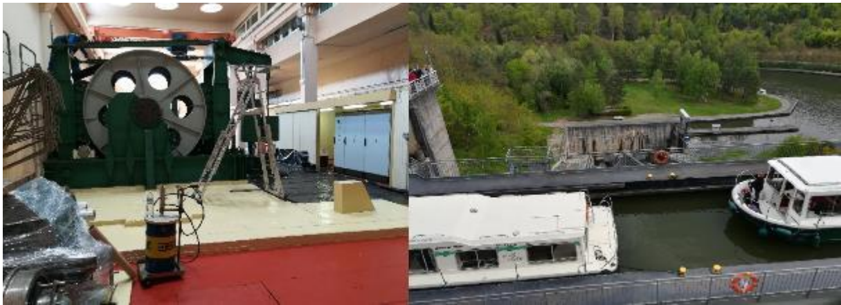
Figure 9 Salle des machines à gauche et bac du plan à droite (le bief 18 est en contrebas)
