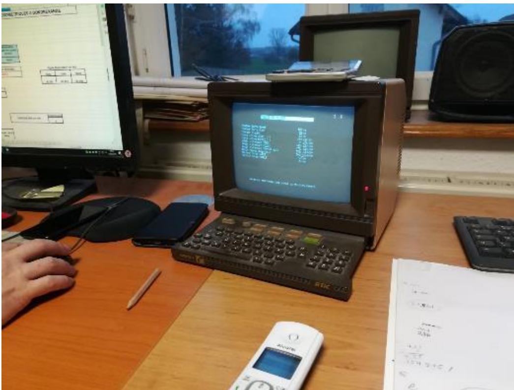
annexe 17 PC de Gondrexange et Minitel qui permet de manipuler les barrages de Nitting et Lorquin
