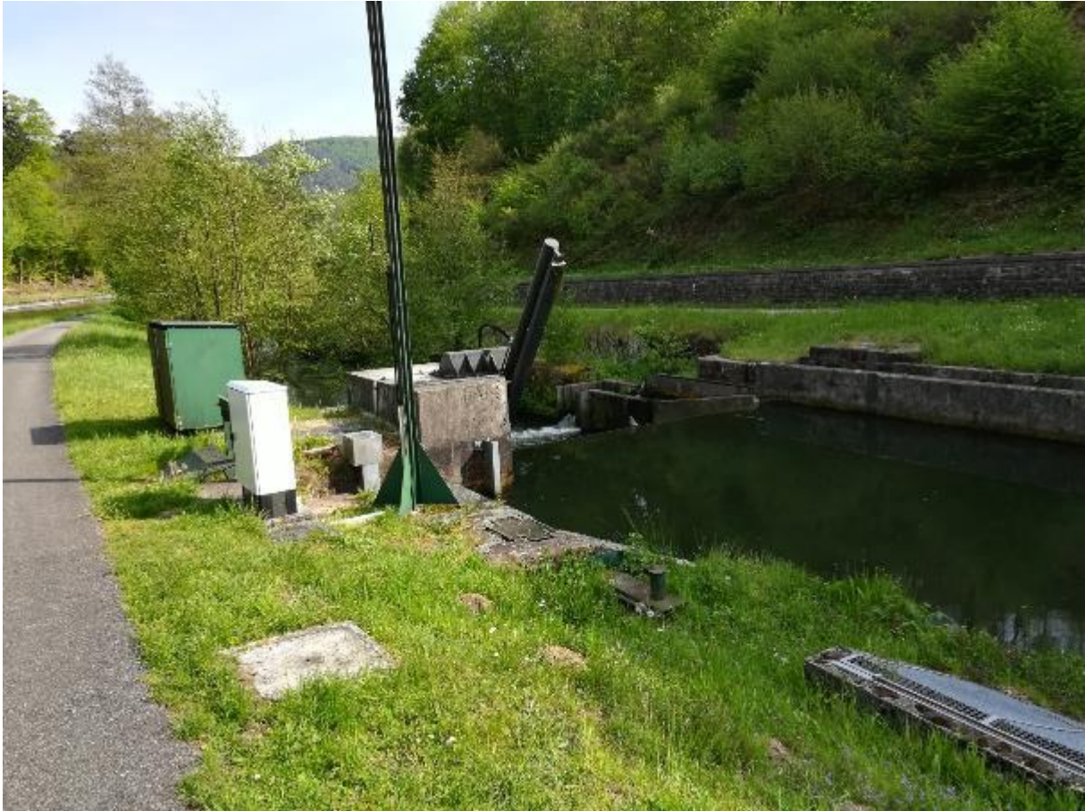
Figure 12 Prise d'eau 26 avec le barrage à clapet en arrière-plan et la vanne à droite sur le sol
