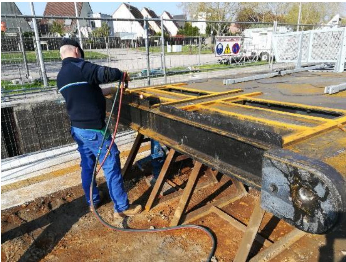
annexe 19 Exemple de maintenance spécialisée : un chaudronnier travaille sur une vantelle
