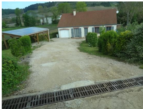
Photo 11 : Maison sous le niveau du sol à Auxey-Duresses
