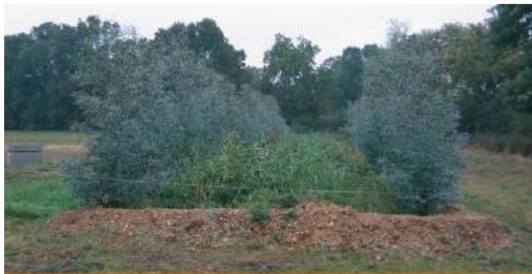
Figure 31 : Photo d'un massif filtrant végétalisé
