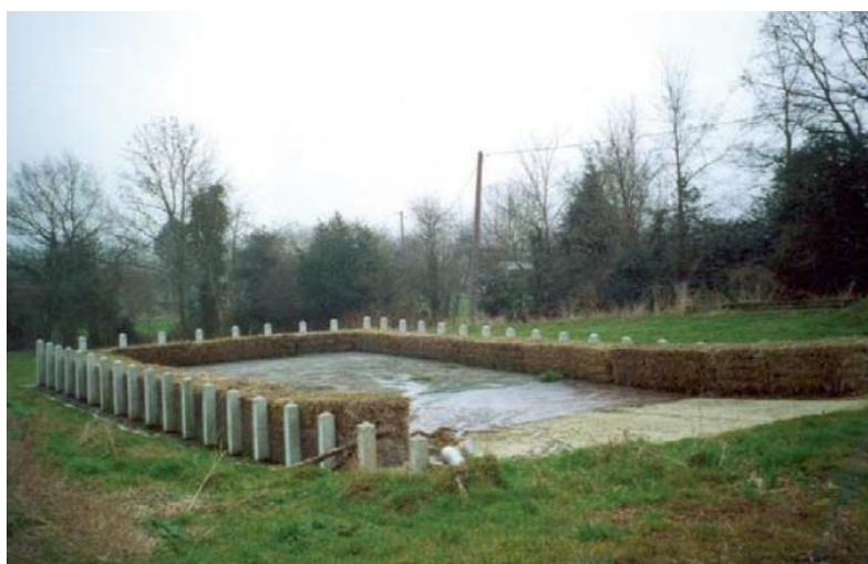
Figure 26 : Photo d'un filtre à paille (Source : Chambre d'agriculture 51)
