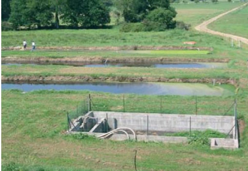
Figure 28 : Photo d'une lagune avec en premier plan le bassin tampon sédimentation
