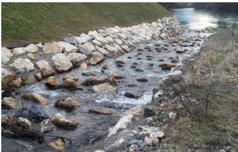
**Figure 4 : Rampe en enrochements régulièrement répartis à la Combe de Lancey (38) (source : ARRA, 2015)**
