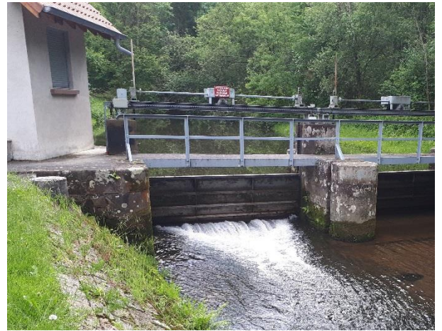
Figure 17 : Vanne du barrage de la PE de Lorquin, sur la Sarre Blanche
