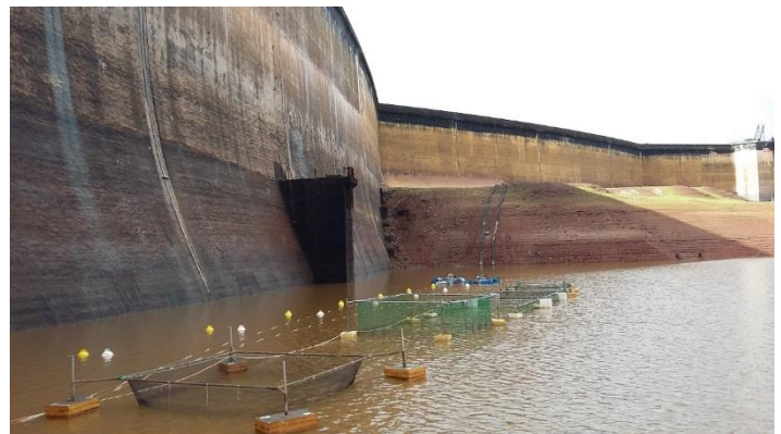
Figure 20 : Barrage de Champagny, pendant sa vidange
