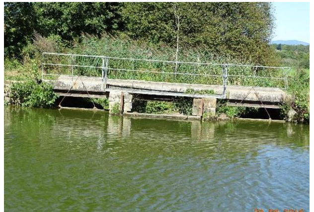
Figure 22 : Déversoir de l'Ecrevisse, CRRBS
