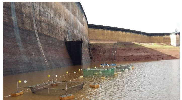
Figure 20 : Barrage de Champagny, pendant sa vidange
