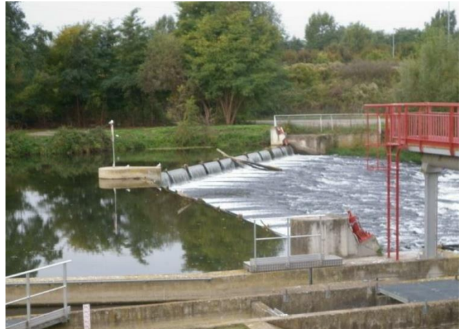
Figure 21 : Barrage de l'III à Colmar
