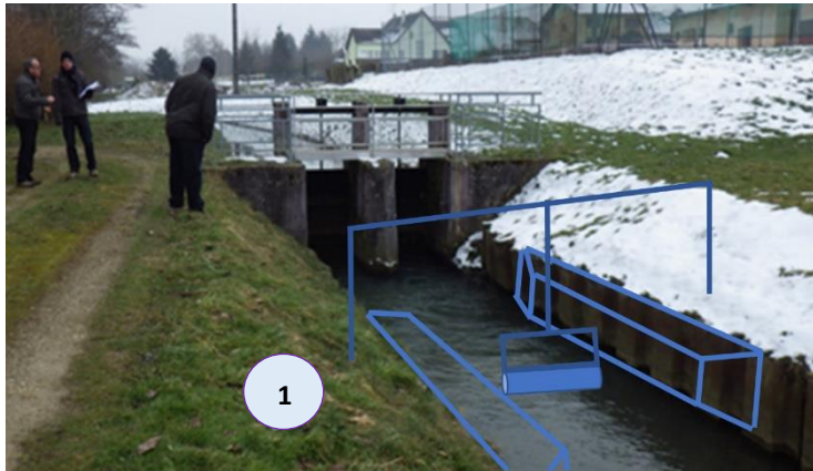
1. Vanne de la PE de la Largue (Friesen) – Etranglement et Cylindre Oscillant
