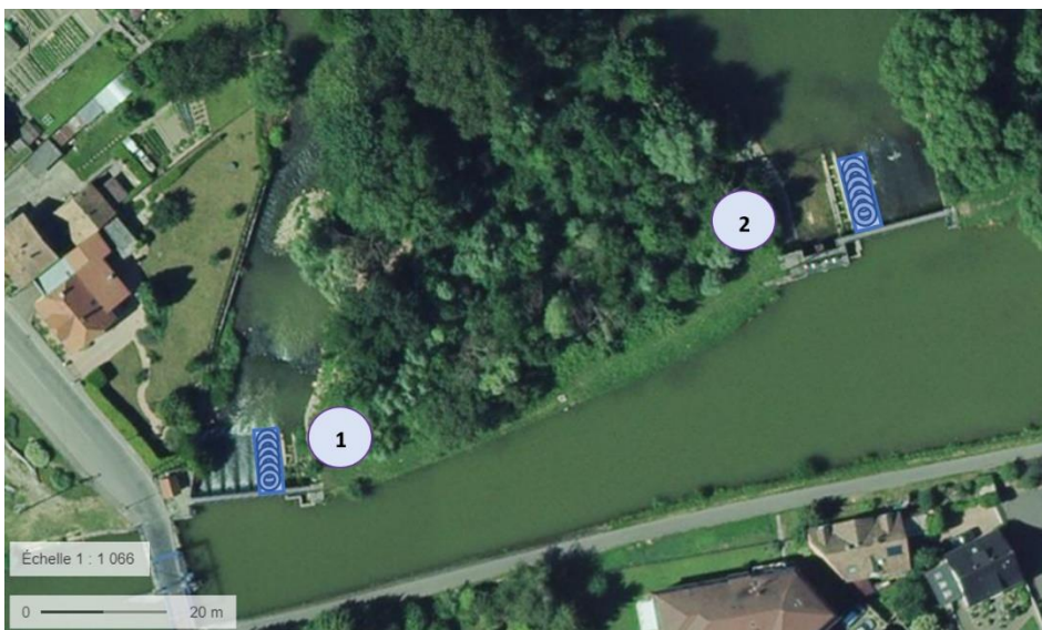
1. Barrage de Zillisheim 1 – Vis d'Archimède Verticale
