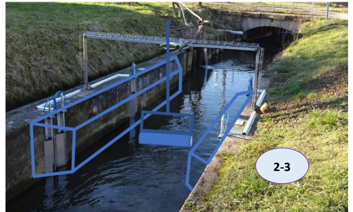
1. Vanne de la PE de la Largue (Friesen) – Etranglement et Cylindre Oscillant
