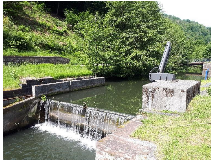
Figure 19 : Barrage clapets de la PE 26 sur la Zorn
