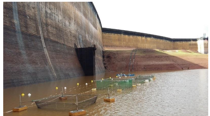
Figure 20 : Barrage de Champagny, pendant sa vidange
