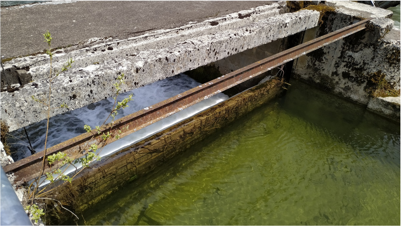
Annexe 5 : Barrage du lac Saint-Point, les surverses se trouvent de chaque côté du barrage (image personnelle)
