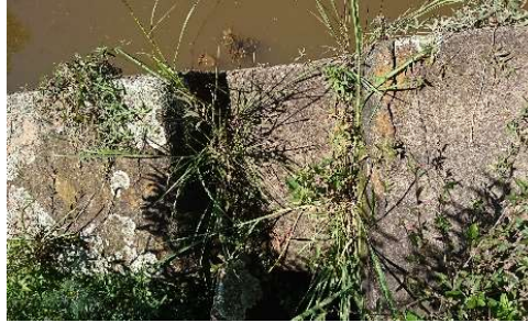
Figure 12: Trop-plein du barrage 3
