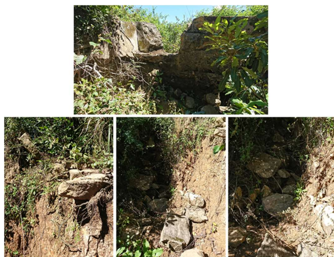
Figure 11: Reste du canal de trop plein (à l'aval du barrage 3)
