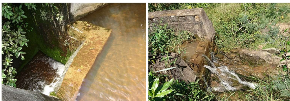
Figure 7: Déversoir du barrage 1 (à gauche), fin du canal (à droite)
