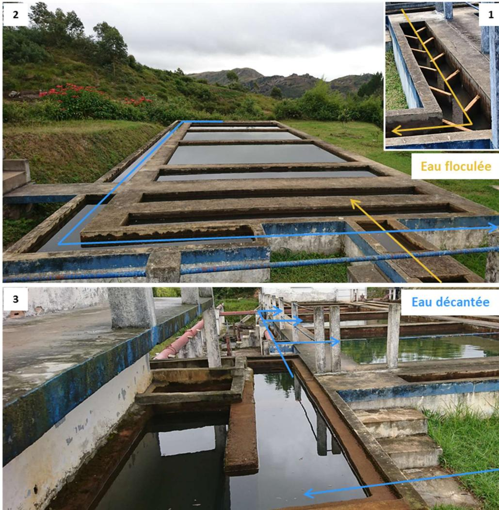
Figure 26: Décanteur 2
