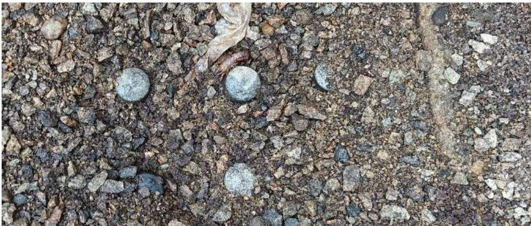
Figure 29: Plancher du filtre
