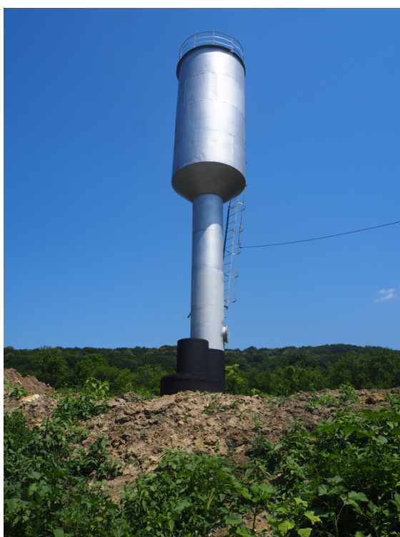
Annexe 16 : Château d'eau en acier nouvellement construit à Seliște, zone amont du bassin de la Nirnova, Moldavie
