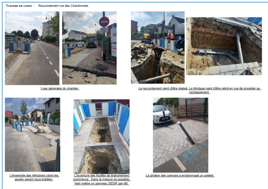
Figure 14 : exemple d'une Fiche de suivi de chantier (21/05/2019)
