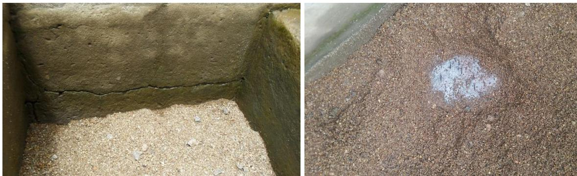
La granulométrie utilisée pour la filtration est trop importante. Le génie civil est en mauvais état. La hauteur d'eau dans les filtres est inférieure à la hauteur de sable. Le principe des tamis est à revoir.
