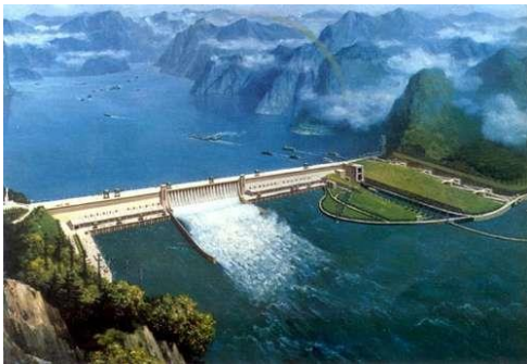
Figure 1 : Barrage des Trois Gorges
