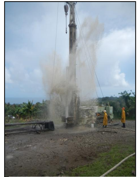
Forage sur le site de Perpigna
