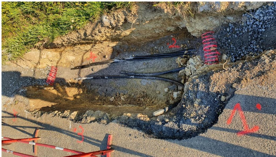
Figure 13: Aperçu de la tranchée ouverte d'une longueur d'environ 5 mètres pour 1,5 de profondeur (photo personnelle).
