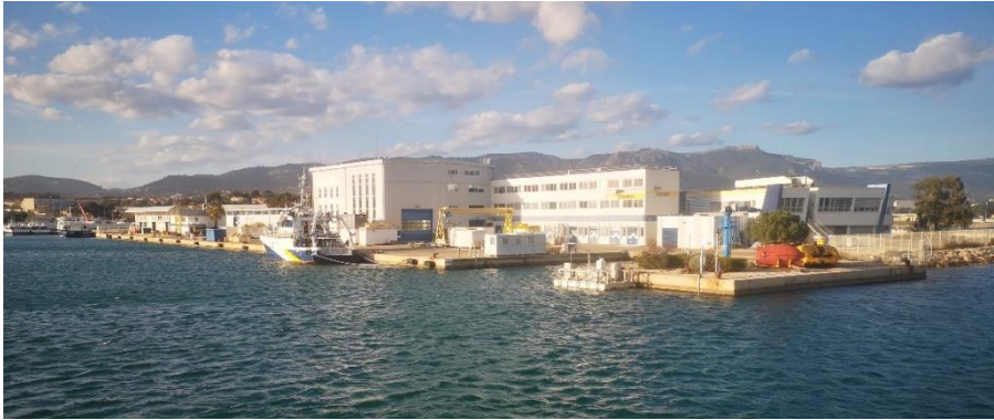
Figure 6: Site de départ de la mission GRAVIMOB2 - Photo réalisée par mes soins.
