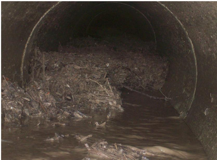
**Figure 30 : Canalisation encombrée de sarments suite à un évènement pluvieux (source : SNC-Lavalin)**
