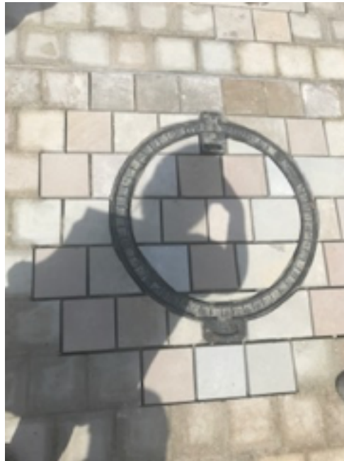
Figure 9 Modèle de trappe à remplissage pour regard sur la place du Lieu de Vie (Crédit :Nissrine El Malki)
