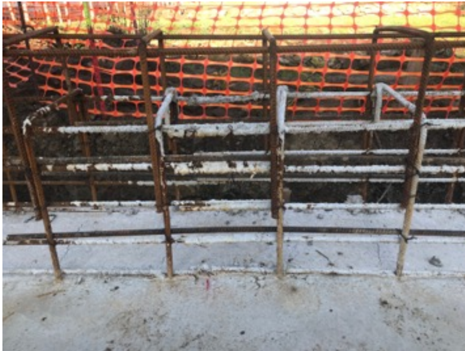
Figure 13 Assemblage des armatures du muret (Crédit : Nissrine El Malki)
