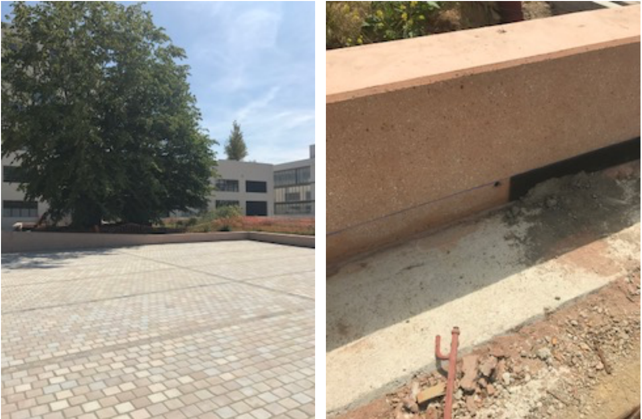
Figure 15 Muret à l'état final (Crédit : Nissrine El Malki)
