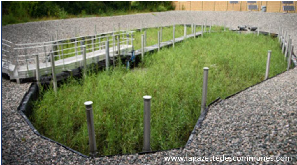
Figure 19. Exemple d'un filtre planté de roseaux à écoulement vertical à Marcy-l'Etoile (69)
