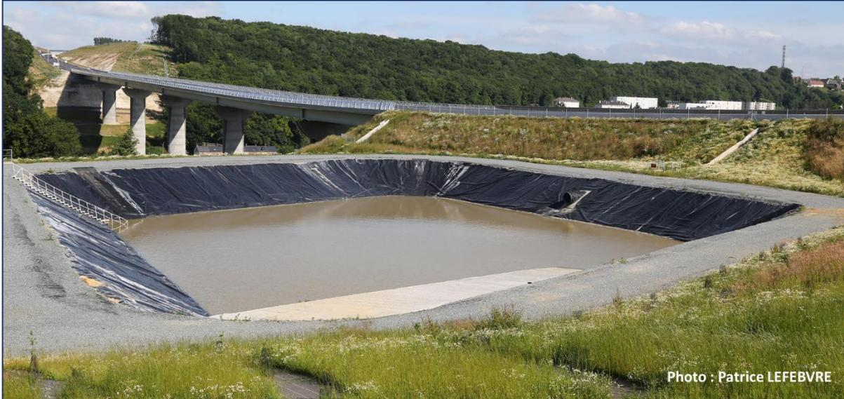
Figure 13. Exemple d'un bassin de retenue-décantation des eaux pluviales à Villers-Écalles (76)
