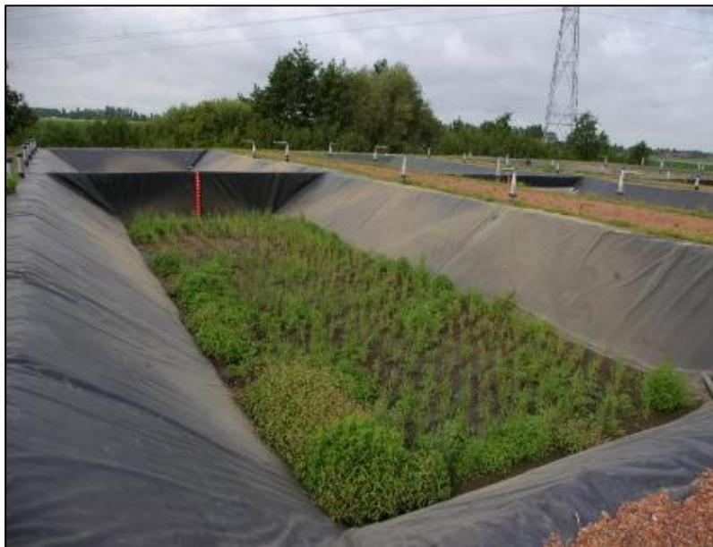
Figure 3 : Lits de Séchage Plantés de Roseaux (Source MEL)
