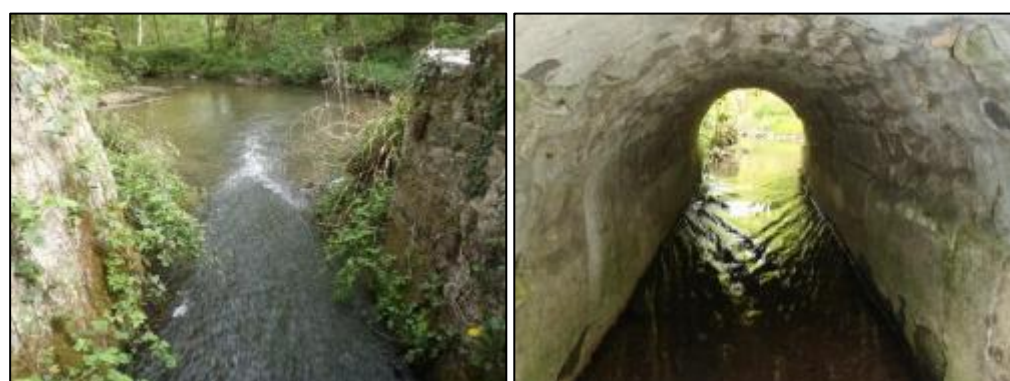
Figure 28: Photographies de l'ouvrage R6. Gauche : vue sur l'aval de l'ouvrage, radier et fosse de dissipation. Droite : Vue sur la maçonnerie interne et le radier
