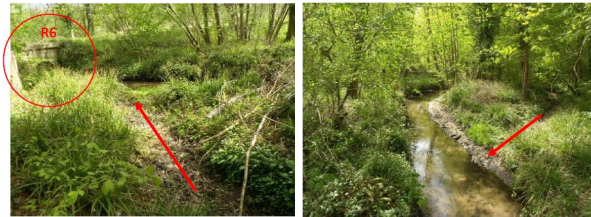
Figure 31 : Photographies de l'ouvrage R7, vue aval. Les flèches rouges indiquent la sortie du canal de décharge se jetant en amont de R6 (source : CARICAIE)
