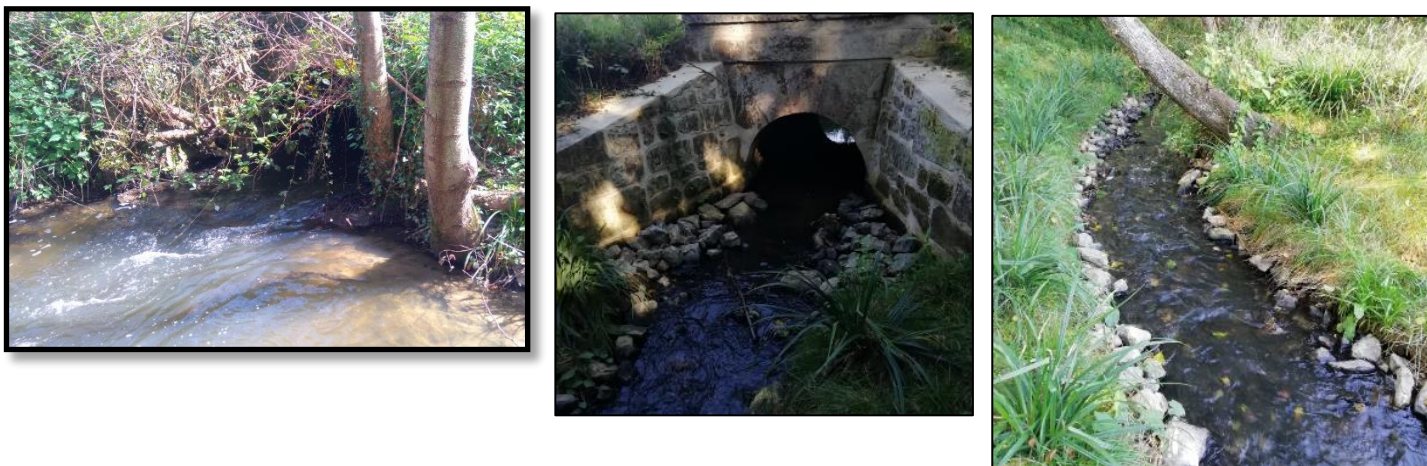
Figure 44 : Photographies de l'ouvrage R3 aval avant travaux en 2017 (à gauche), après travaux en 2020 (au centre) et du ru de Berne aval en 2020 (à droite) (source : ONF)
