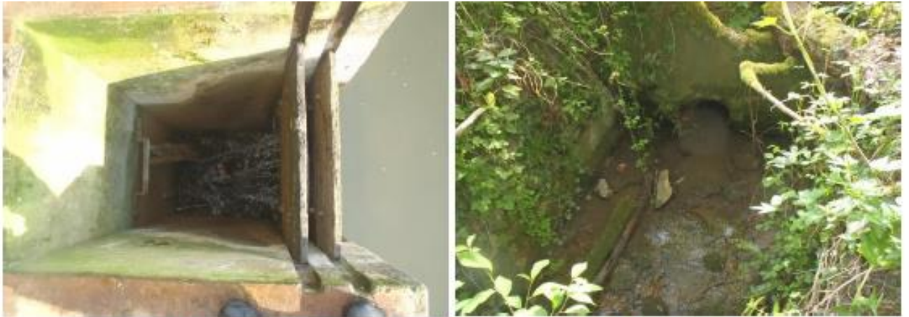
Figure 105 : Photographies de l'ouvrage E4. Gauche : vue de dessus, batardeau et intérieur embâclé/envasé du moine. Droite : vue de la sortie à l'aval du moine, vers le Ru de Berne. (Caricaie, 17-04-2020).
