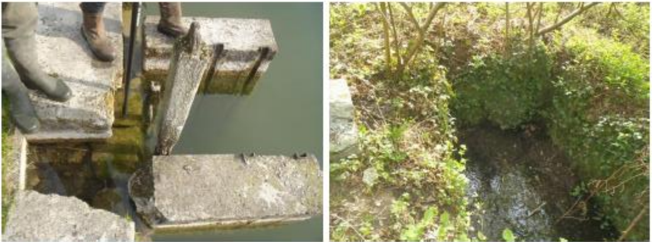
Figure 110 : Photographies de l'ouvrage E6. Gauche : vue de l'ouvrage à l'amont. Droite : vue de la sortie de l'ouvrage à l'aval. (Carçale, 17-04-2020).
