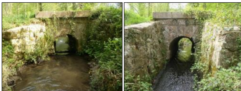
Figure 27 : Photographies de l'ouvrage R6. Gauche : vue sur l'ouvrage depuis l'amont ; Droite : vue sur l'ouvrage depuis l'aval
