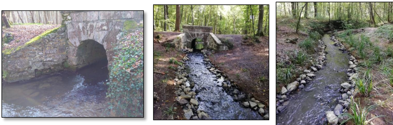
Figure 43 : Photographies de l'ouvrage R5 aval avant travaux en 2017 (à gauche), après travaux en 2020 (au centre) et du ru de Berne aval (à droite) (source : ONF)
