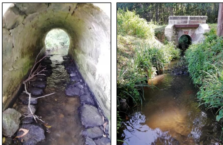
Figure 45 : Photographies de l'ouvrage R2 et du ru de Berne après restauration en 2020 (source : ONF)
