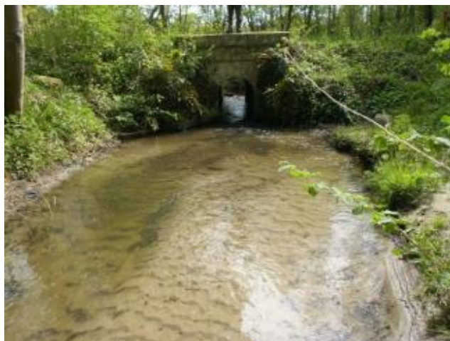
Figure 33: ouvrage R7bis. Gauche : vue sur l'aval de l'ouvrage et la fosse de dissipation. Droite : vue sur l'aval de l'ouvrage menant à R7 (source : CARICAIE)
