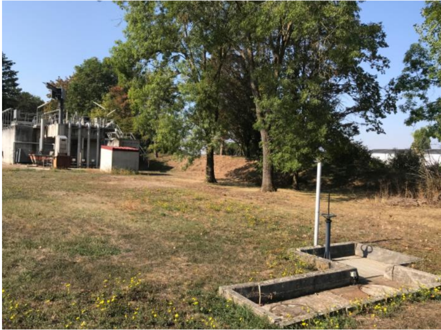
Figure 36 : Zone d'installation des UMD de location
