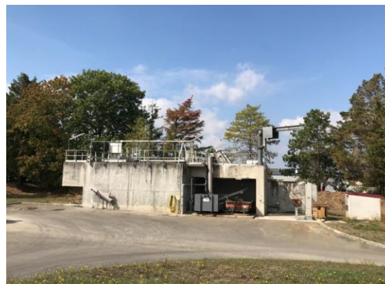
Figure 30 : Zone d'installation pour l'inertage
