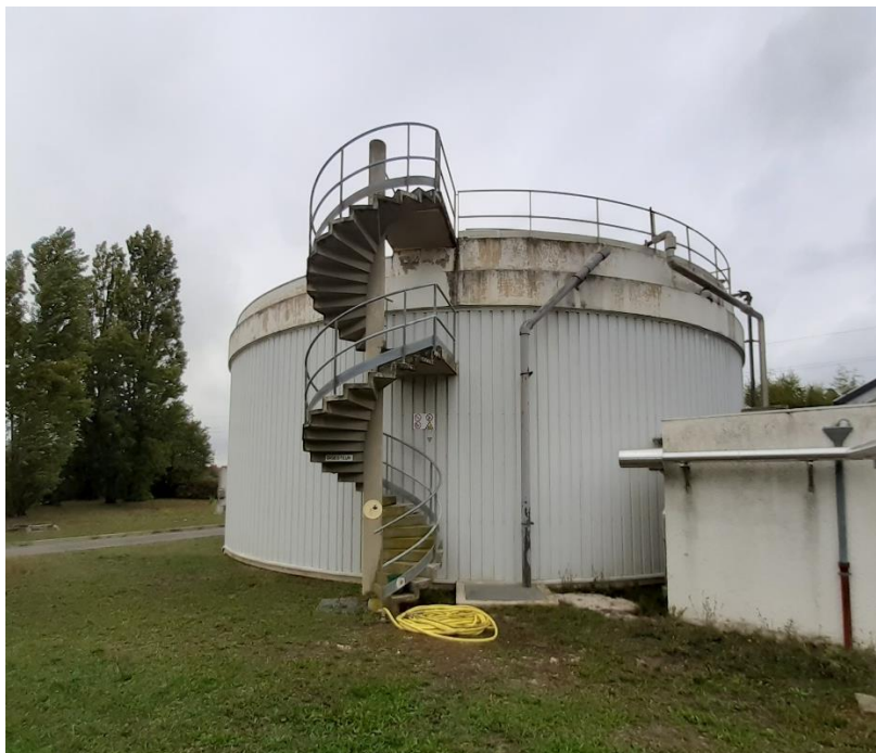
Figure 23 : Digesteur de la station de Chevigny
