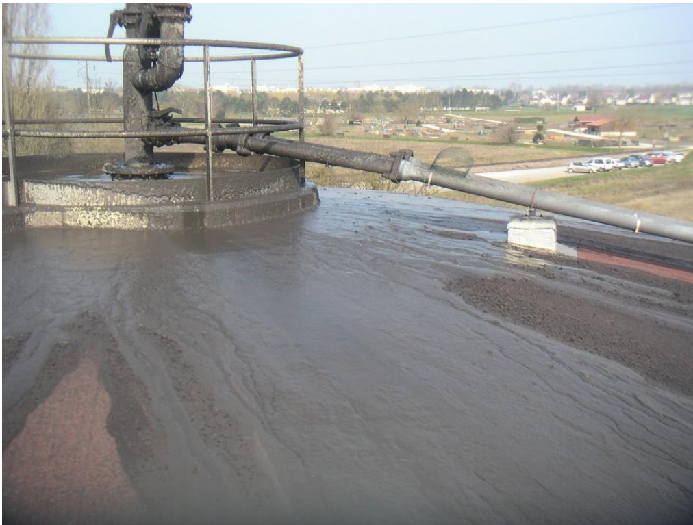
Figure 20 : Moussage du digesteur (2015)
