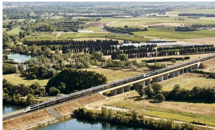
Figure 2 : La ligne ferroviaire traversant les Costières de Nîmes constitue une barrière écologique (Ocvia, 2020)
