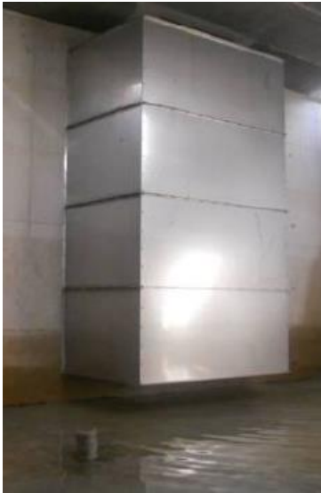
Figure 54 - Exemple de paroi siphonide
