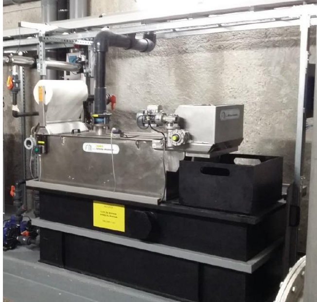
Figure 59 - Filtre à déroulement de media
