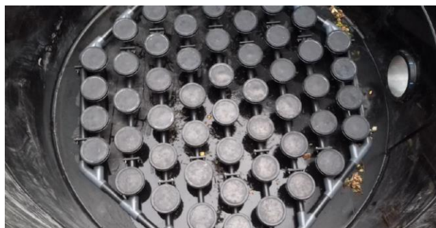
Figure 58 - Diffuseurs d'oxygène
