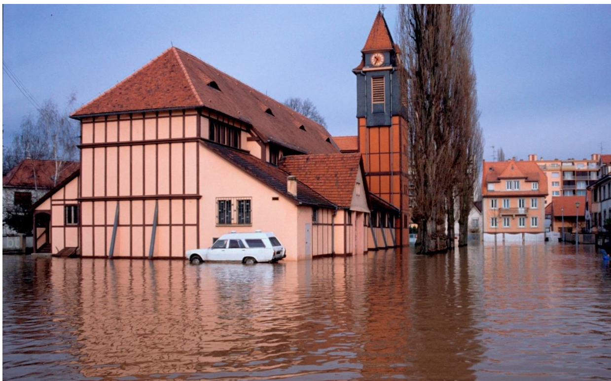
Eglise Saint-Arbogast, quartier de la Montagne Verte (Strasbourg), crue de l'Ill et de la Bruche de février 1990 (Crédit photo : Monsieur TISSIER)
