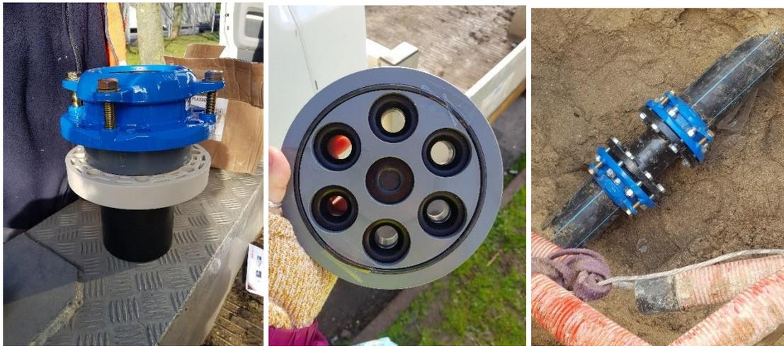
Figure 42 : Limiteur de débit Berfelt (à gauche et au milieu) et Bayard (à droite)
