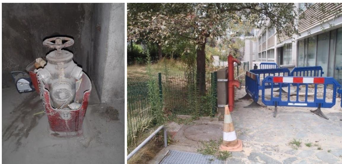
Figure 11 : PI en mauvais état et BI en zone de travaux
