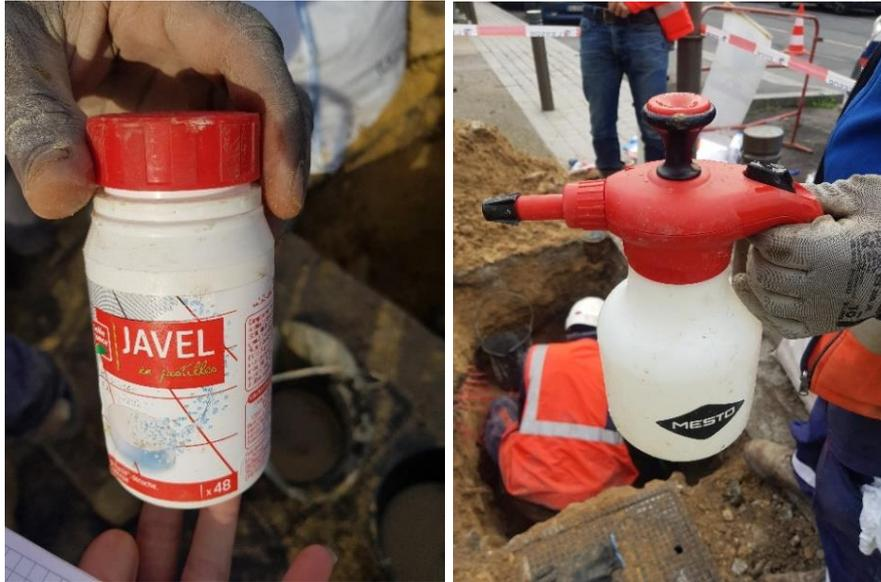
Figure 45 : Produit et outil de désinfection du limiteur de débit
