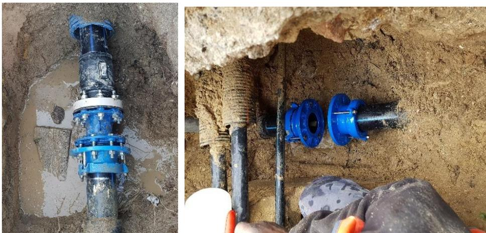
Figure 46 : Mise en place du limiteur de débit
