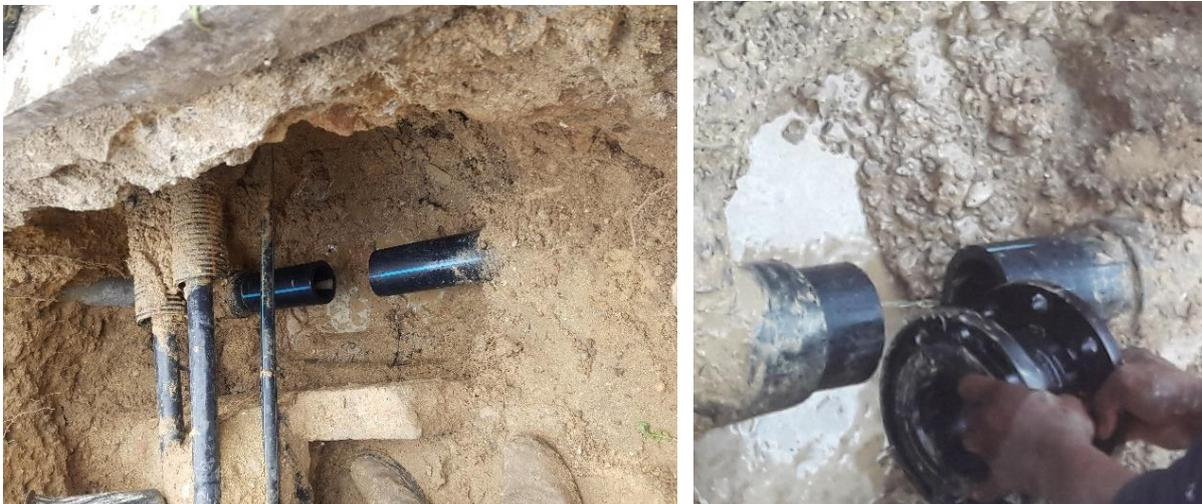
Figure 44 : Etape de coupage de la conduite pour la mise en place d'un limiteur de débit
