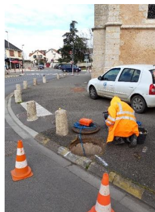
Figure 17 Regard du capteur PT2 Lucé, France, source Chartres métropole
