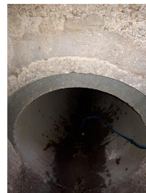
Figure 15 Point de mesure (PT2) Lucé, France, source Chartres métropole
