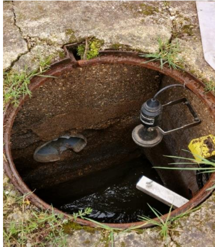
Figure 16 : Exemple d'une sonde de hauteur au niveau du collecteur
