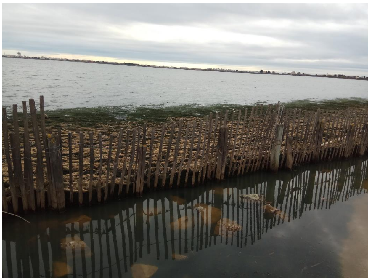
Figure 22. Dépôts de sables, vases et herbes bloqués par une barrière sur l'étang de Palavas, Maison de la Nature de Lattes, novembre 2019, M.Bertrand
