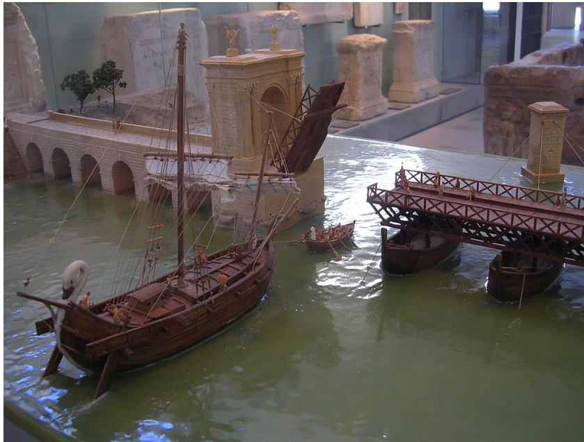
Figure 22 : Maquette issue du Musée romain d'Arles, représentation d'un des arcs du pont de bateau sur le Rhône 959 .
