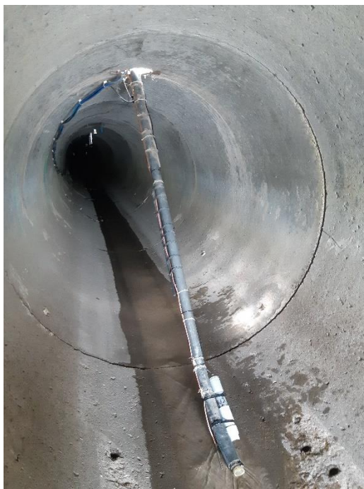
Figure 35 : Installation de la sonde sur la canne de mesure de la hauteur d'eau
