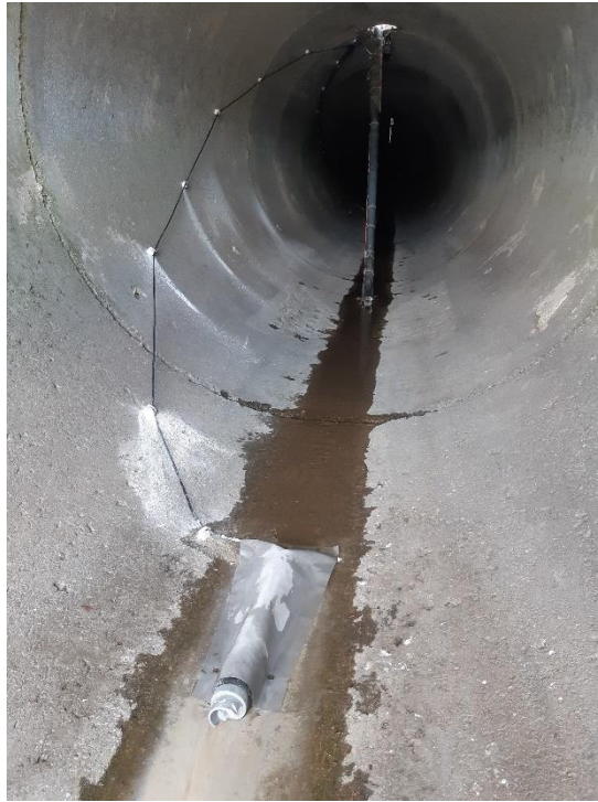
Figure 37 : Installation de la sonde dans l'écoulement (26 juillet 2021)
