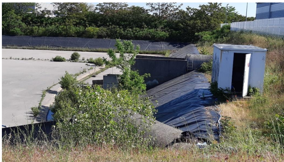
Figure 31 : Bungalow de mesure OTHU du bassin de rétention (1er juin 2021)
