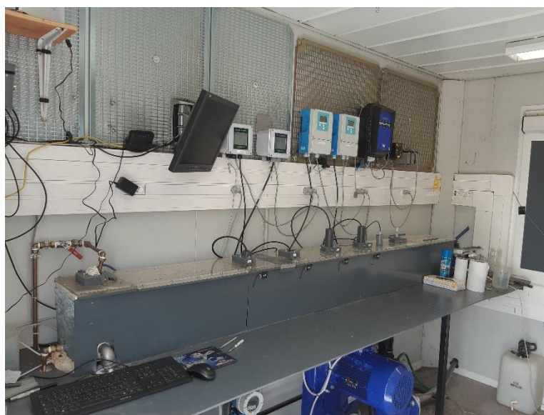
Figure 32 : Canal de dérivation d'une station OTHU (1er juillet 2021)
