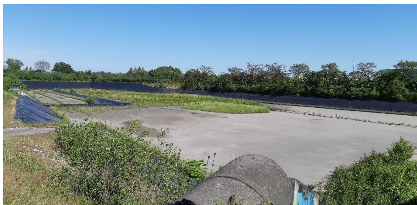
Figure 27 : Bassin de rétention du site Django Reinhardt (1er juin 2021)
