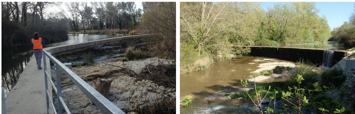
Figure 29 : Seuil du Moulin du Pont (gauche) avec une crête abaissée, seuil de la Marie-Thérèse (droite)
