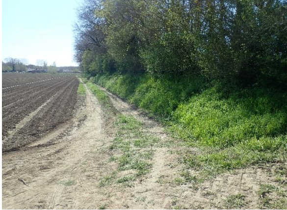
Figure 35 : Digue de 2 m de haut en rive droite du Vallat du Grand Ruisseau, pk 1,150
