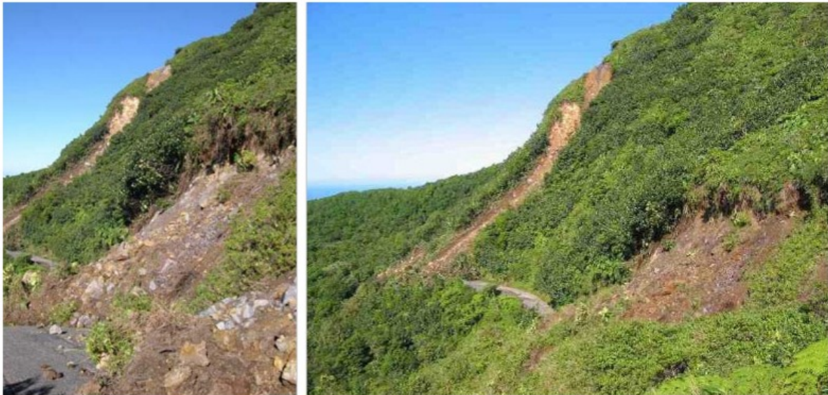
Figure 5: Éboulement sur la route du volcan de la soufrière suite au séisme de novembre 2004, Photos : Sophie Lignier
