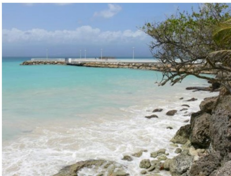
Digue de protection de la station balnéaire du Grosier en Guadeloupe, @France-voyage.fr
