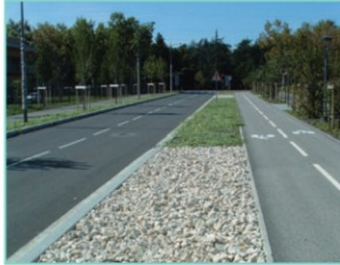
Exemple de tranché drainante, Source cahier technique agence de l'eau Loire Bretagne
